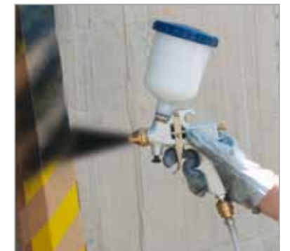
Покрасочные работы: просто и красиво
